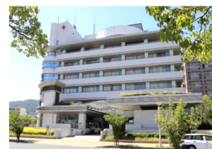
日本赤十字社兵庫県支部・ 兵庫県赤十字血液センター合同庁舎
